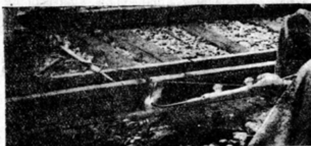
Fig. 2. — Sudura se execută simultan de doi sudori.
