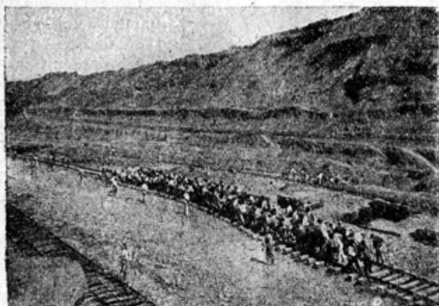
Fig. 8. În timpul săpăturilor dela Culebra se mută șinele pe care circula trenurile de transport a pământului săpat. (După John Foster Fraser, The Panama Canal ).
