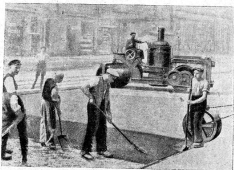
Fig. 3. Construcția unei străzi de asfalt bătătorit pentru trafic greu.
