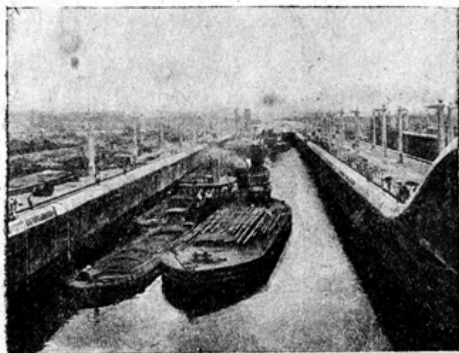
Fig. 13. Ecluse la Miraflores . Cheiurile se înalță dela nivelul inferior la cel superior în dreptul porților. (Foto York & Son, Londra).
