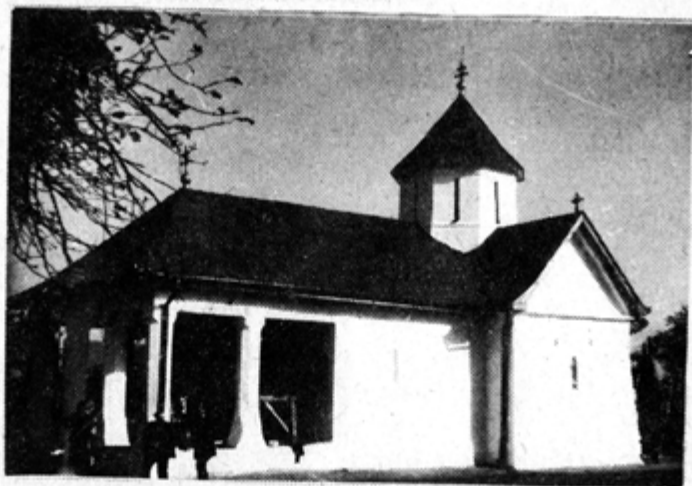
Fig. 4. Biserica Mănăstirii „Săraca” după încheierea lucrărilor de consolidare
