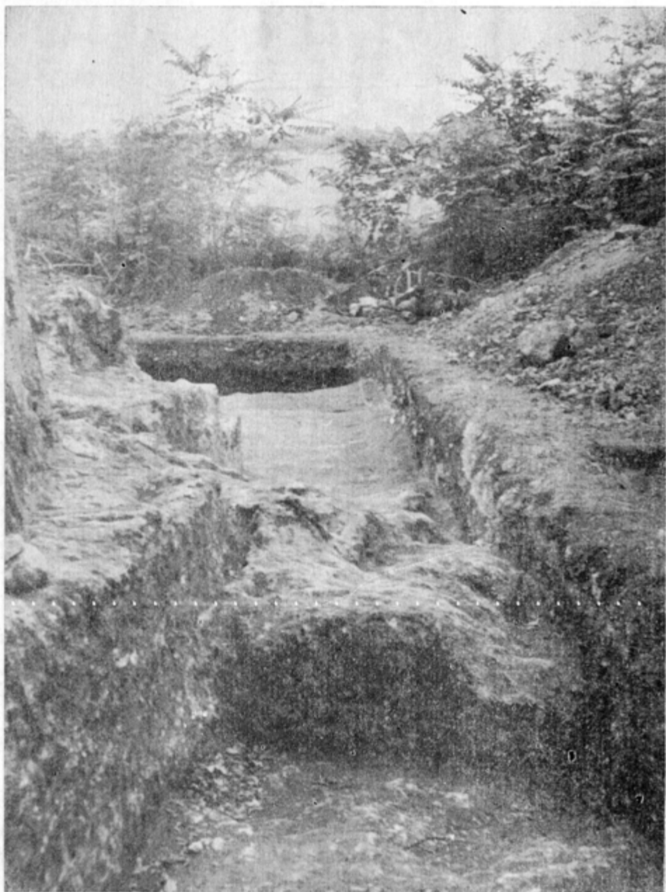
Fig. 2. Fundația săpată în stîncă a absidei laterale a vechii biserici.
