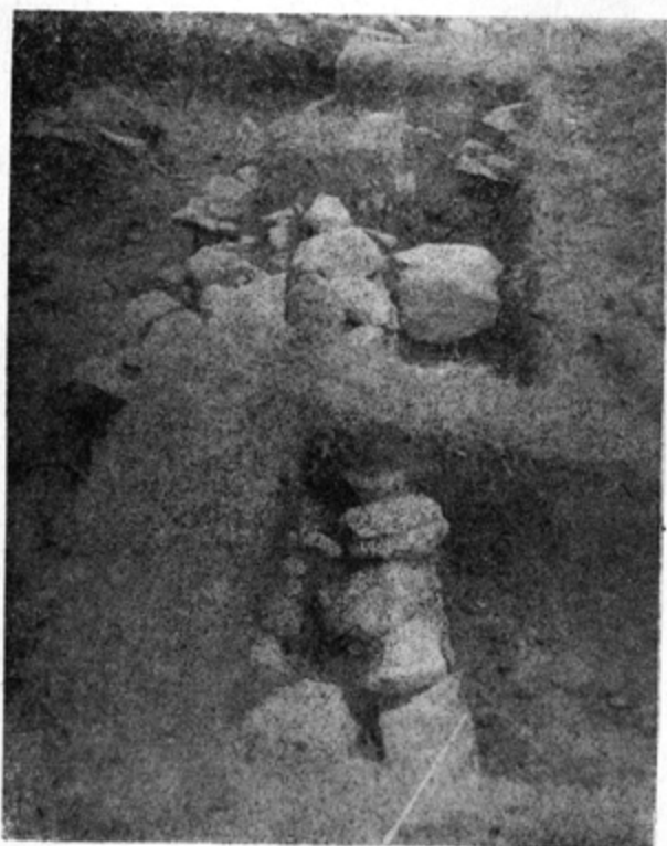
Mănăstirea Cerna. Fundațiile clădirii anexă.
