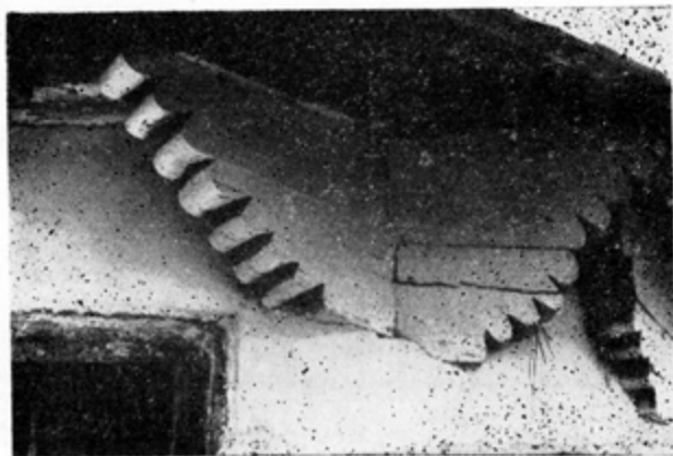
Fig. 1. Îmbinare în „aripi de fluture” de la biserica din Curtea
