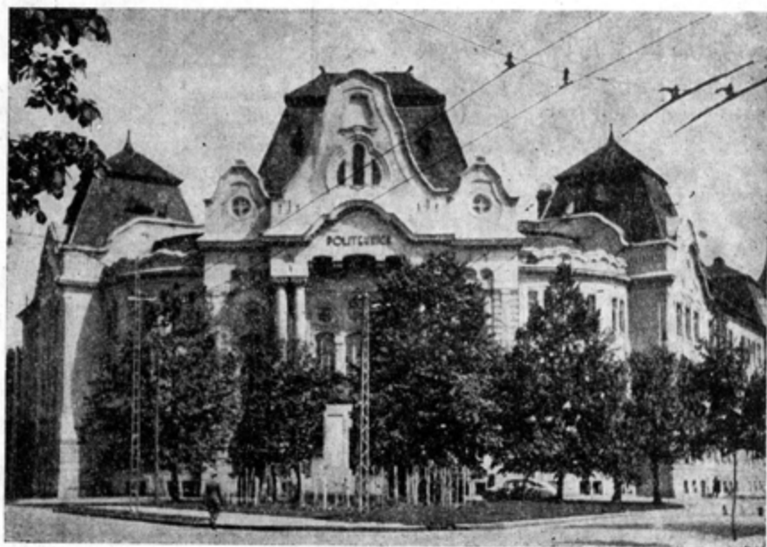
Localul Facultății de electrotehnică și al Facultății de construcții
