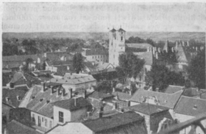
Lugoj — Vedere generală — Catedrala gr. cat.
