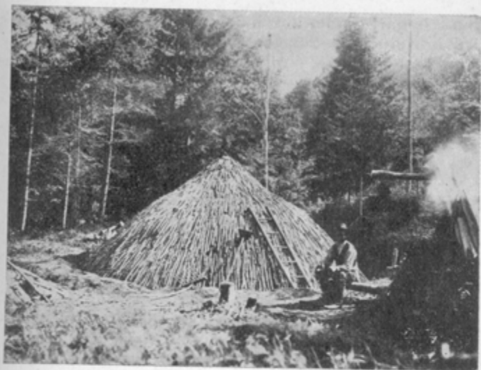
Clădirea lemnului pentru arderea cărbunilor
