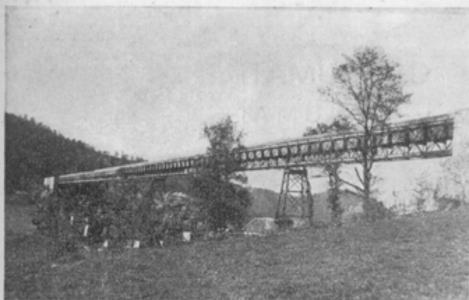
Apeductul dela Secul
