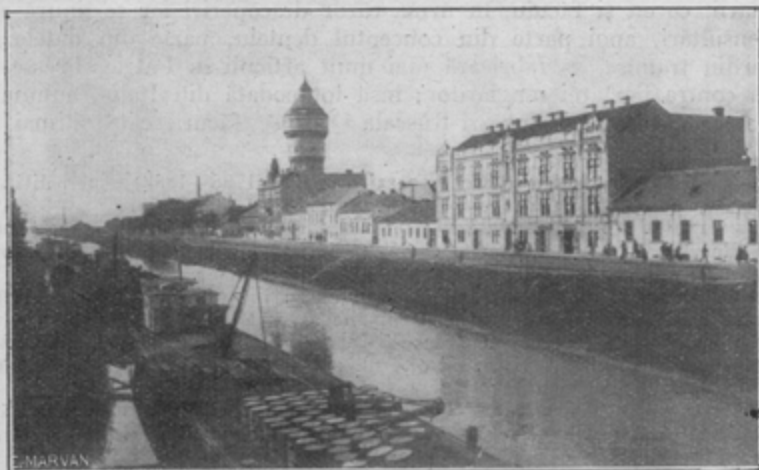
Canalul navigabil al Begheului la Timișoara.
