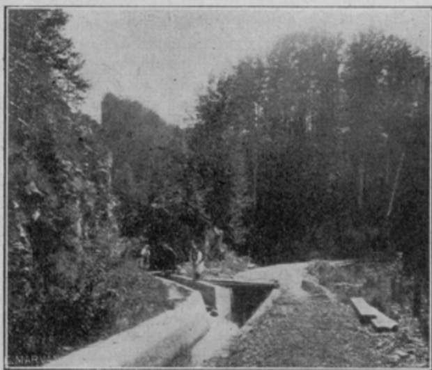
Canal de transportat lemne pe domeniile Reșiței.
